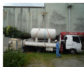
ガス8気圧分充填して往復 回収装置・真空ポンプ
