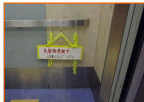
札はエレベータ内部にコンバクトに常設
