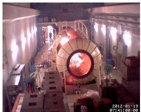
絶縁タンク解体撤去
