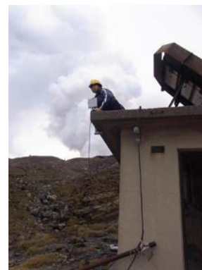
馬の背観測室アンテナ取付け
