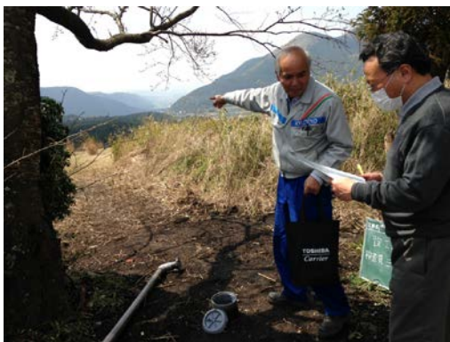
汚水配水管施工完了検査
