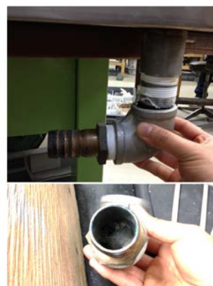
図5 機械類のトラブル対応例。岩石カッターの排水管に岩石が詰まり水が流れなくなっていた。（上）排水管を外したところ。これにホースを接続し排水口に水を流している。（下）岩石の詰まり。
