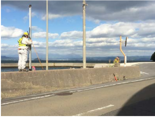
桜島島内一周道路にて測量を実施
