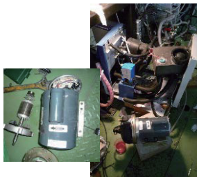
RFQ冷却水ポンプ軸受交換
