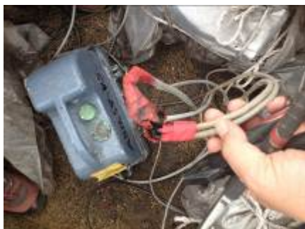
図 1. ケーブルの破損(地震計)
