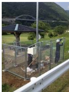
図 21. フェンス設置立会
