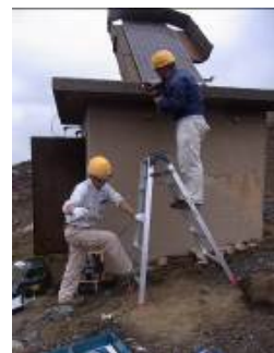
図 3. アンテナ取り付け
