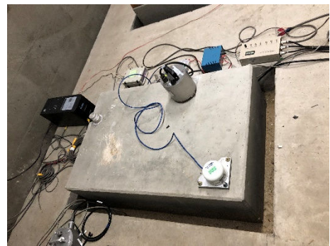
図 3 傾斜計（手前右下）
