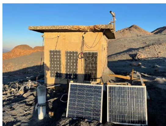
写真 2 ソーラーパネル再設置
