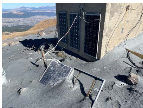
写真 1 噴火によって被害を受けたソーラーパネル
