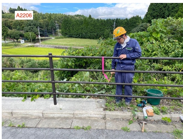
写真1 消失した点の再設置
