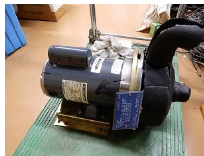
写真1 取り外した純水チラーのポンプ
