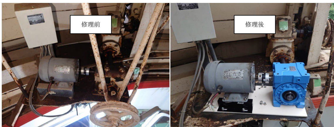
図-8 ドームスリット開閉用減速機交換修理
